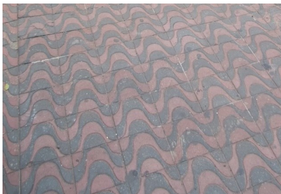
Figura 5. Revestimento de calçada da Quadra 4 – Concreto estampado.
