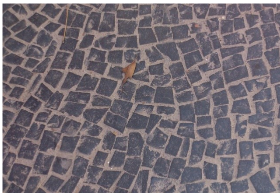
Figura 4. Revestimento de calçada da Quadra 6 – Pedra portuguesa.
