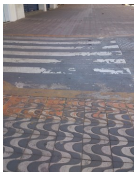
Figura 11. (a) Entrada para Viela da Quadra 6; (b) Continuidade entre passeios da Quadra 6.
