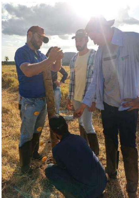
Figura 1. Instalando os arames com os isoladores na fazenda IF Goiano.
