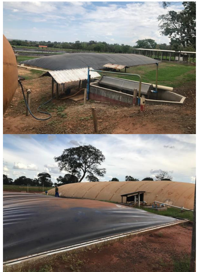
Figura 2. Biodigestor em operação instalado em propriedade no Estado de Goiás, região de Rio Verde. Fonte: Os Autores.
