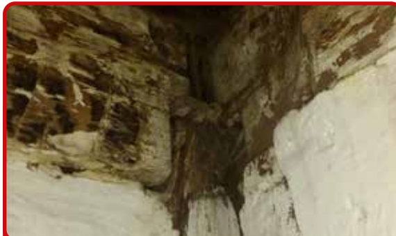
Estrutura do pilar de madeira deteriorado – Museu de Trindade.
