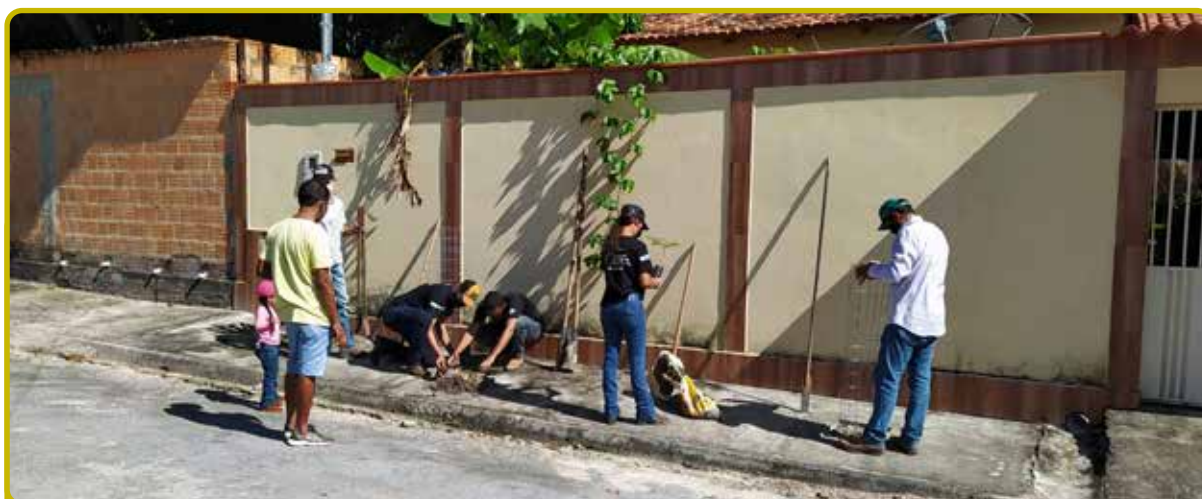
Projeto sendo executado nas ruas de Campos Belos.
