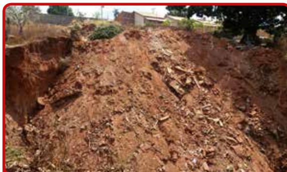
Vista Geral da Erosão sendo entupida com entulhos, agosto de 2017. Foto: Arquivo pessoal, 2017.
